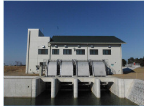
藤曽根排水機場(外観)
