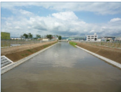
葉の木堀排水路
